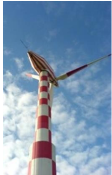
Gedsermøllen (1957) 24 m wingspan
